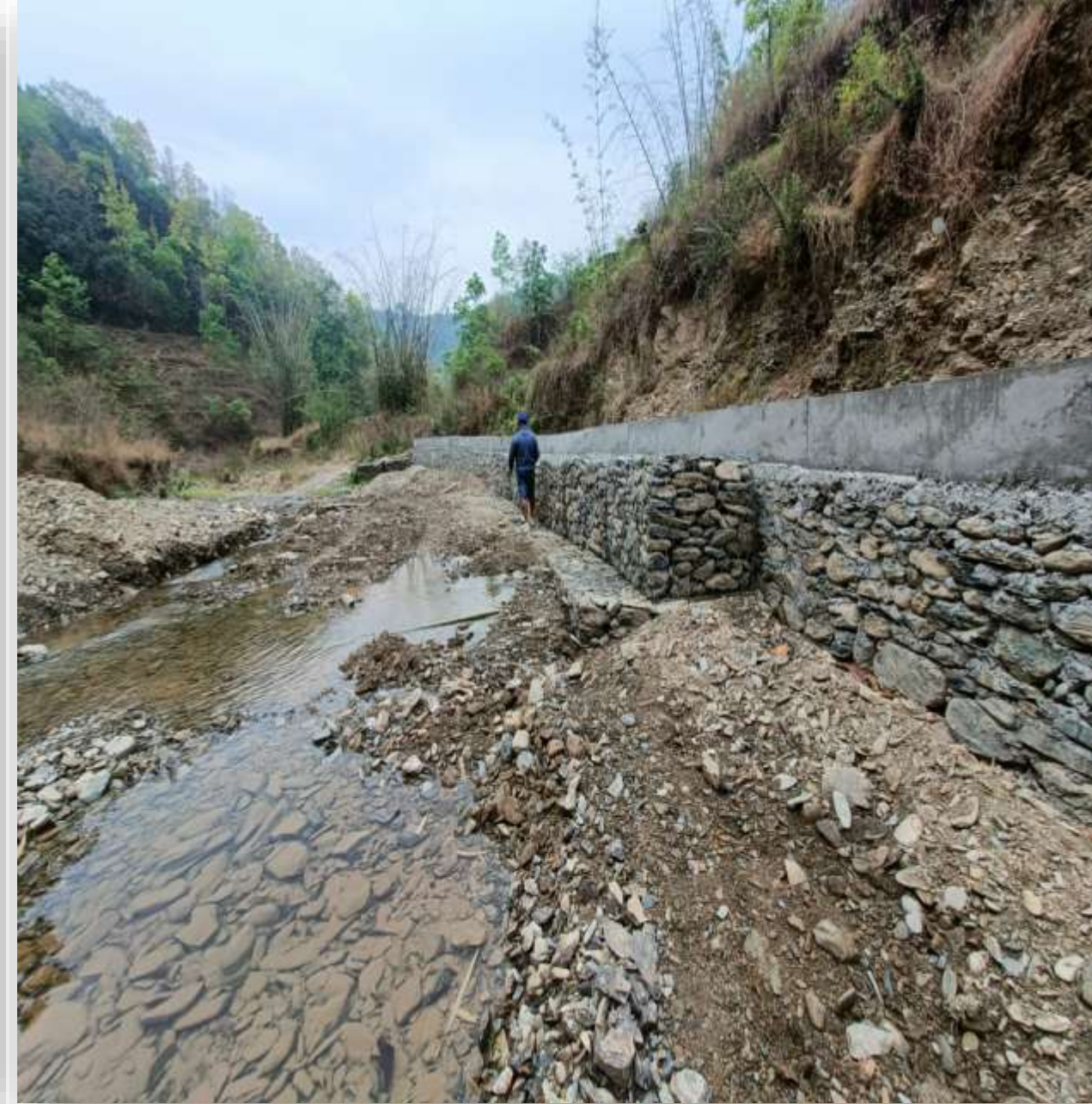
राकेखोला नदी नियन्त्रण तथा तटबन्ध निर्माण वडा नं. ५
